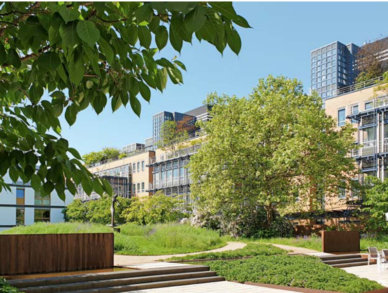
Etwa 35.000 m 2 Büro- und Gewerbeflächen im ehemaligen Forschungs- und Entwicklungszentrum Heidelberg werden durch die GGH derzeit umfassend umgebaut. Zur Finanzierung der emissionsmindernden Grundsanierung hat die GGH Schuldscheindarlehen begeben
